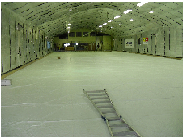
⑨防水シート敷き
