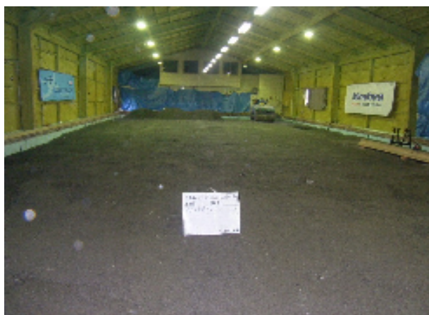
⑤碎石転圧敷き
