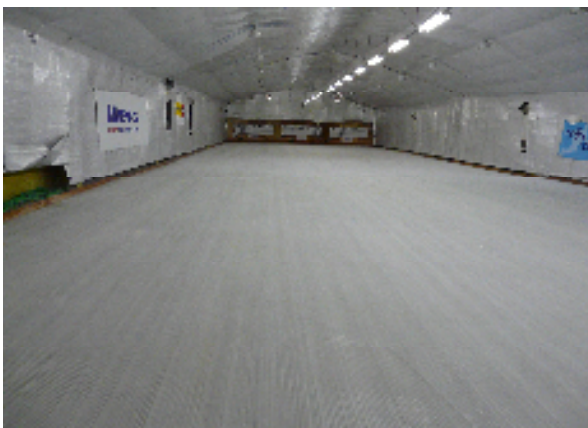
⑪工事完了
