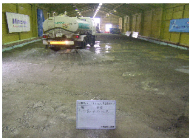
④割りぐり石散水締め
